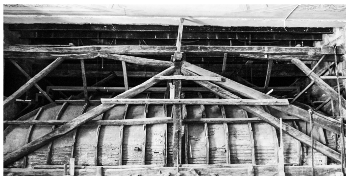
Fig. 2. Struttura in legno con appendini in metallo che sostiene il volto del Salone.
